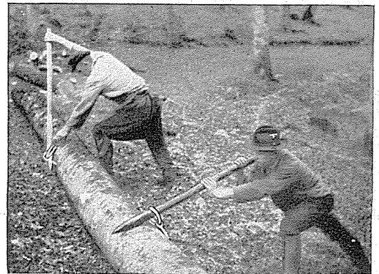
Abb. 6. Das Festhalten des einen Wendehakens beim Umsetzen des anderen.
