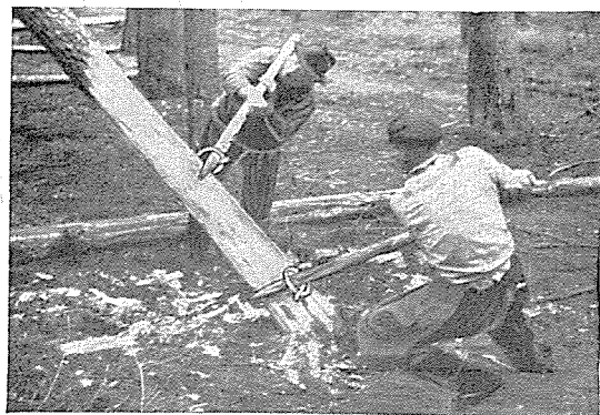
Abb. 7. Das Lösen eines hängengebliebenen Stammes durch Drehen.
