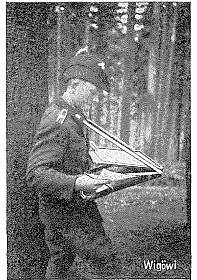
Nr. 26. Das Schreibbrett ohne Regenschutz. Der Aufschreiber wechselt ein vollgeschriebenes Formular aus und verwahrt es in dem Kasten des Schreibbrettes.
